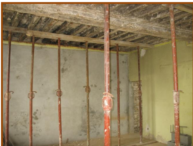
Mise à nue des plafonds et des murs
