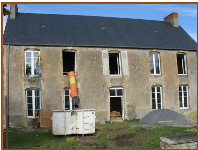
Evacuation des gravats
