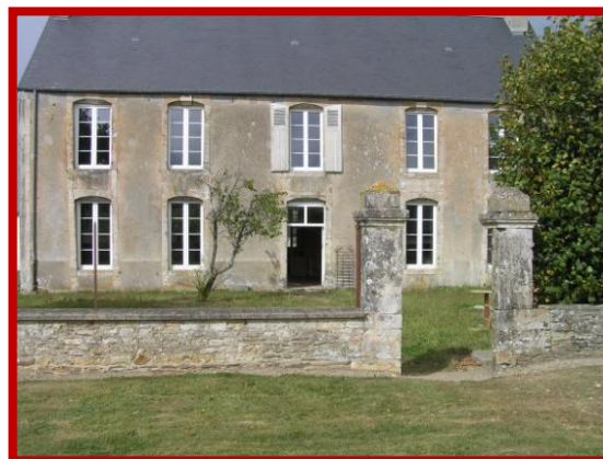
Façade entrée future Mairie
