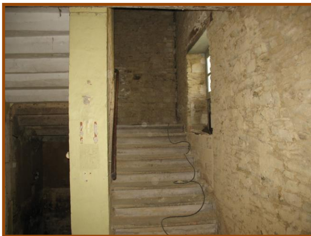
L'escalier en pierre est conservé et sera restauré
