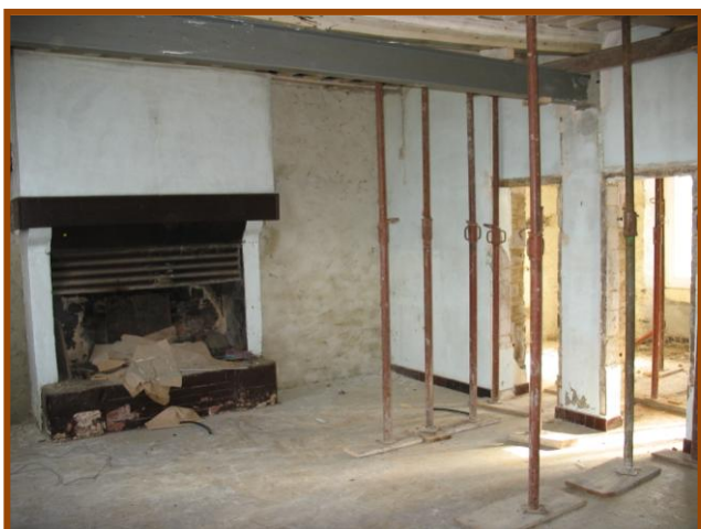
Des étais ont été mis en place dans l'ex salle de séjour
