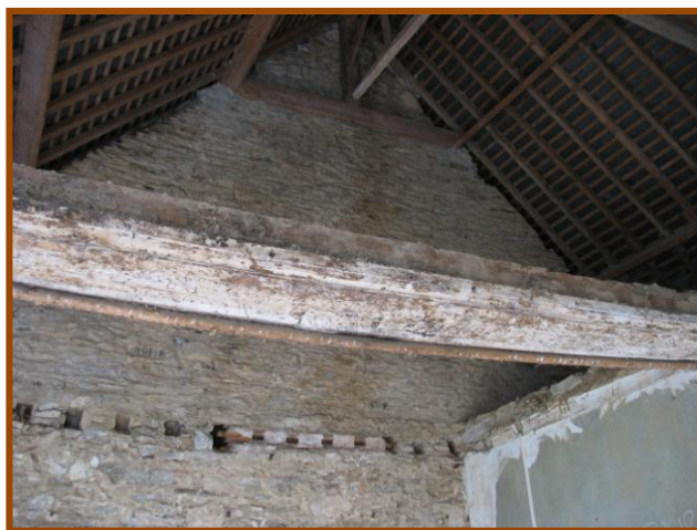
Le plancher du second étage a été démonté
