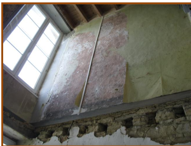
Démontage des planchers
