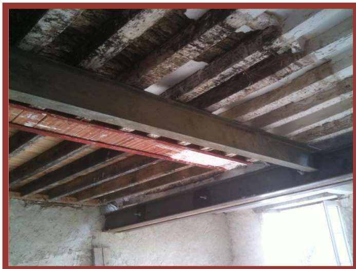
Une poutre métallique IPN a été posée
