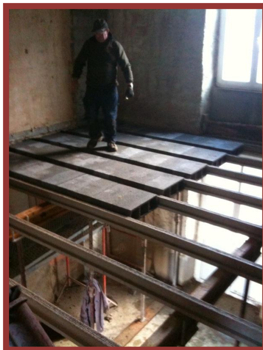
Le nouveau plancher béton est remis en place !
