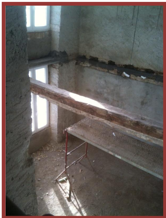
Le plancher d'origine en bois a été démonté.....
