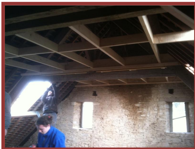
La structure pour les plafonds du dernier étage est en place. Pose des vélux en cours
