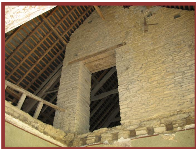
Vue sur le second étage depuis le 1 er étage, le plafond/plancher reste à faire.....
