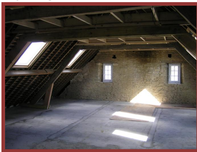
Le second étage est hors d'eau et hors d'air, le plancher béton a été réalisé.....
